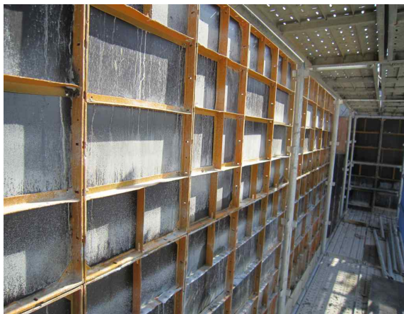
교량 A1 거푸집 설치 상태 현황
