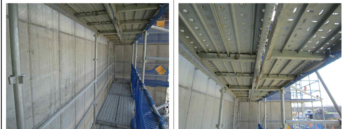
교량 A1 시스템동바리 설치 현황
