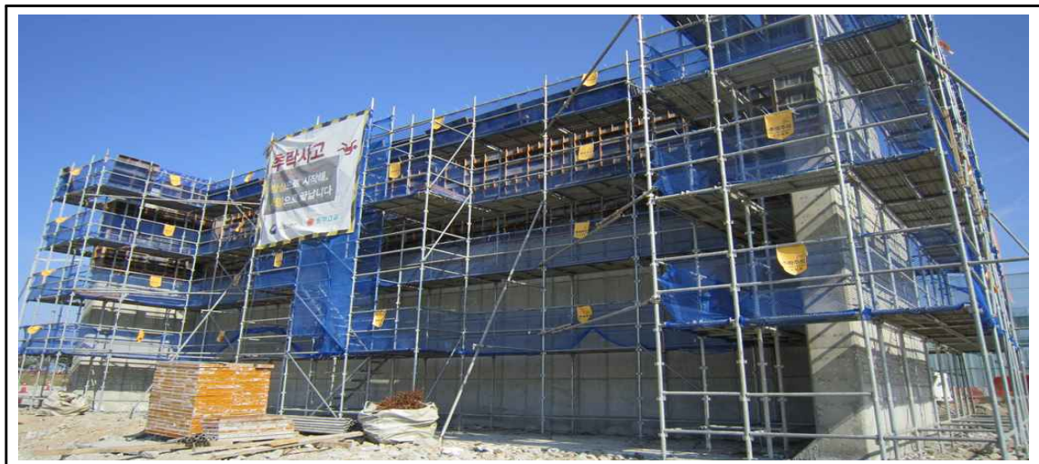
<교대 A1 전경>
