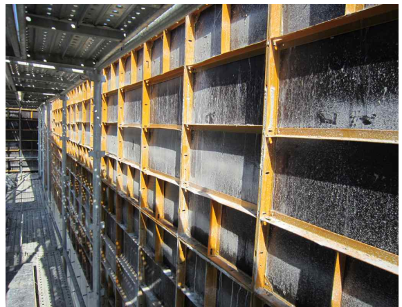
교량 A1 거푸집 설치 상태 현황
