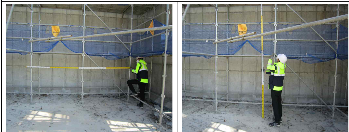
교량 A1 시스템동바리 수직재 및 수평재 간격측정 현황
